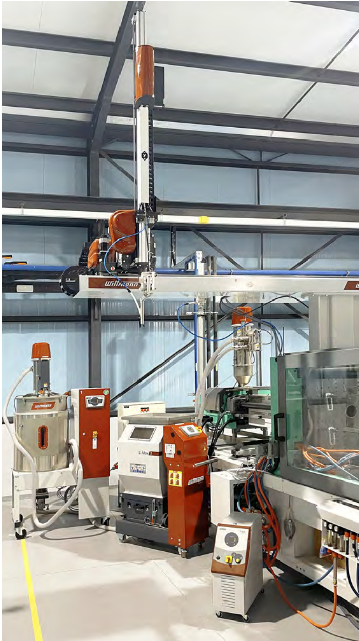
Automatisierung und Peripherie von WITTMANN für eine der bei AB Inject eingesetzten Spritzgießmaschinen: W821 Roboter, Drymax Materialtrockner, Feedmax S3 net Materialfördergeräte, S-Max 3 Mühle und Tempro basic C Temperiergerät.
