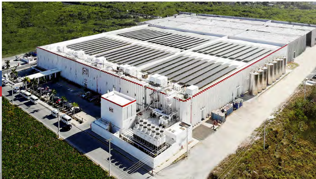
Vista del nuevo edificio Donald Espie Hay, propiedad de Hayco, en Santo Domingo Este, República Dominicana.
