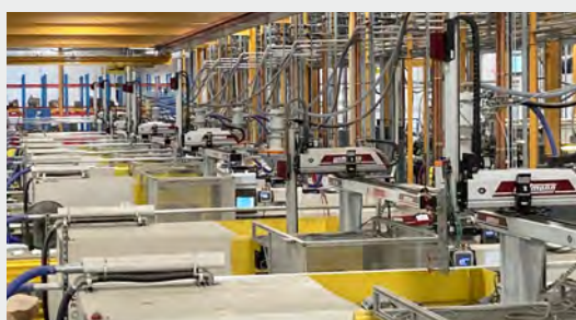
Seite 10: Automatisierung bei Bell, USA
