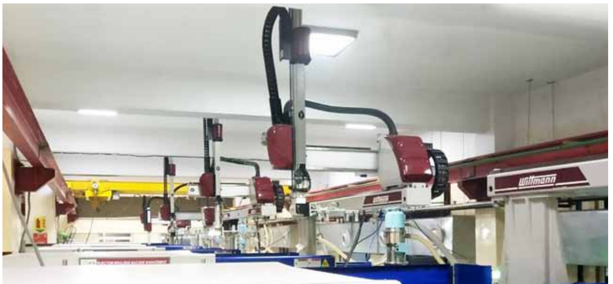
Una vista de la sala de producción de PG Electroplast, la cual muestra los robots WITTMANN.
