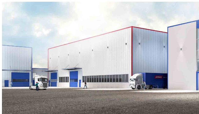
Rot umrandet: Anbau an die bestehende Montagehalle von WITTMANN BATTENFELD in Kottlingbrunn – Fläche: 3.000 m 2 .
