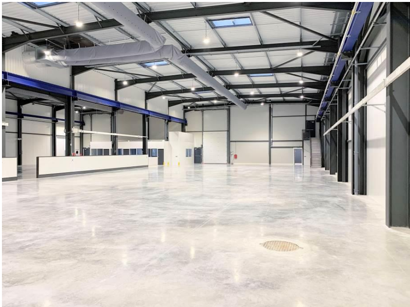
Fig. 2: Hall de Production des nouveaux locaux (Photo: WITTMANN BATTENFELD France)
