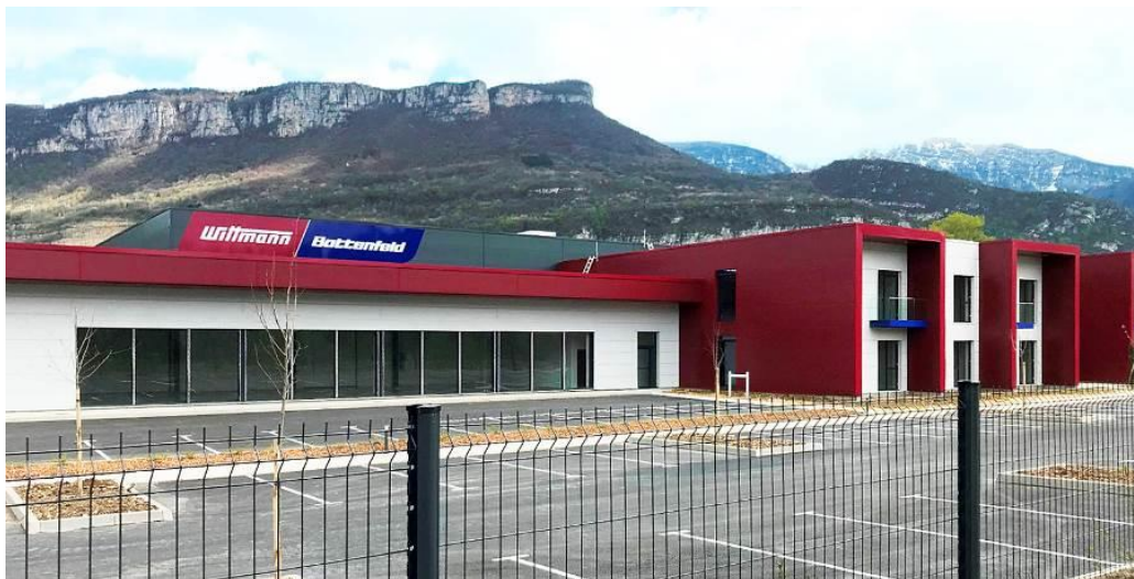
Fig. 1: WITTMANN BATTENFELD France à La Buisse – Showroom et bureaux (Photo: WITTMANN BATTENFELD France)
