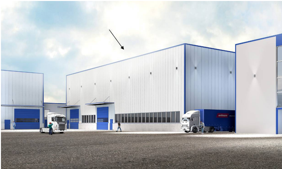
Abb. 2: Anbau an die bestehende Montagehalle in Kottingbrunn – Fläche 3.000 m 2
