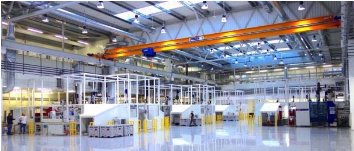
Abb.2: Das Produktionswerk der Buzek Plastic Poland in Plonsk, das nach den Prinzipien der Datenvernetzung nach einem Internet 4.0-Konzept realisiert wurde.
