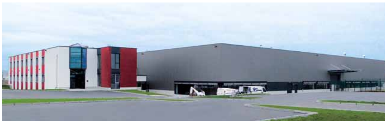
Ansicht des ab sofort von der Schüttgut-Sparte genutzten Neubaus in Wolkersdorf bei Wien.
