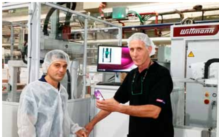
Eitan Ben Shalom, Leiter der IML-Abteilung bei AMRAZ (links), und Ya'akovi Schlosberg, der lokale Servicetechniker von A. ZOHAR Ltd.. Im Hintergrund die bei AMRAZ installierte IML-Anlage.
