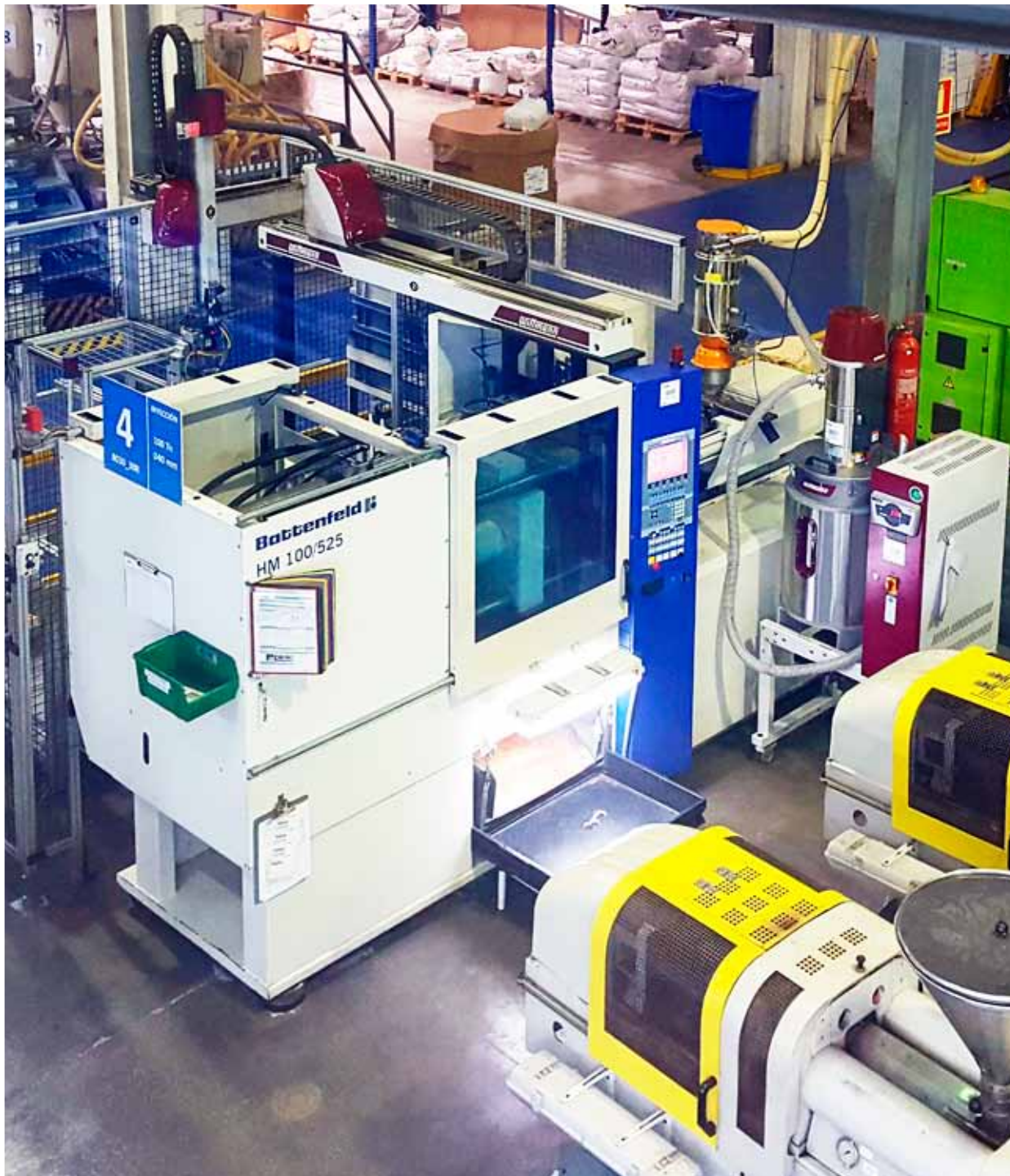
Hydraulische Spritzgießmaschine von WITTMANN BATTENFELD sowie Automatisierungs- und Trocknungs-Equipment von WITTMANN bei Simon in Olot.
