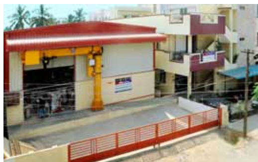
Ansicht des ausgebauten Firmengebäudes der indischen Niederlassung.
