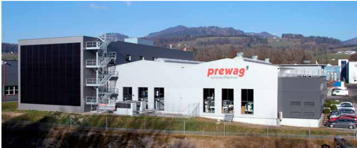
Prewag Firmengelände in Eschenbach-Neuhaus in der Schweiz, Blick von Süden. Am 2016 errichteten Erweiterungsbau links im Bild sind die Sonnenkollektoren zu erkennen.
