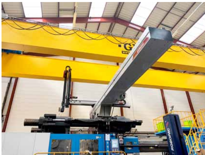
W873XL Roboter von WITTMANN, aufgenommen während der Installationsarbeiten bei BELLI in Bellignat, Frankreich.
