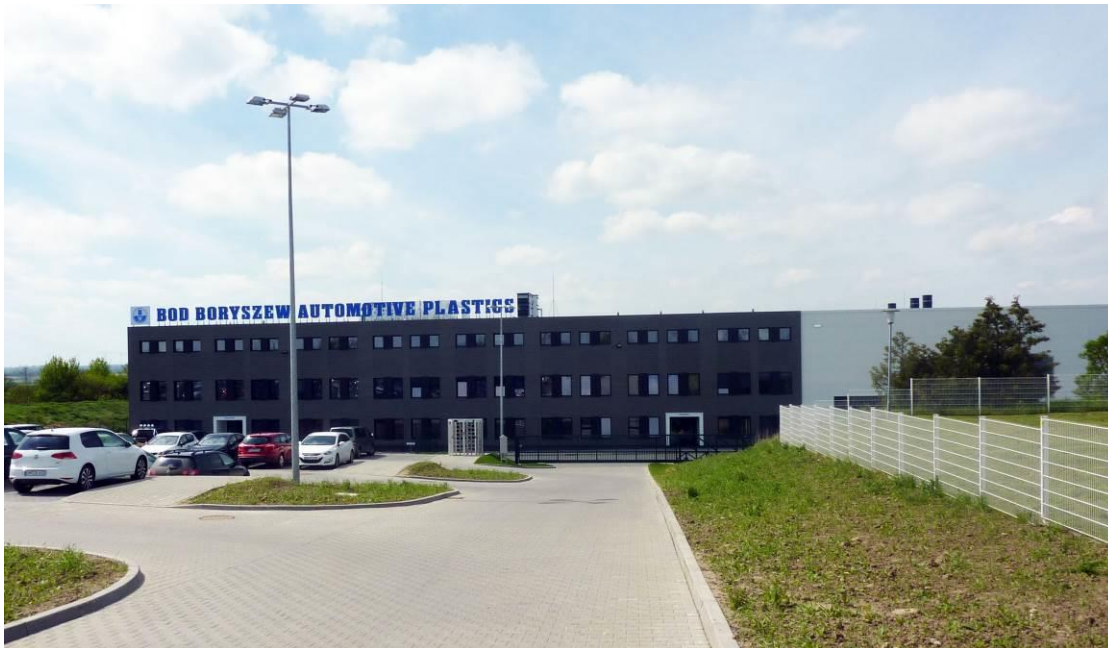
Fig. 1: The new building of Borszew Oberflächentechnik Deutschland in Prenzlau
